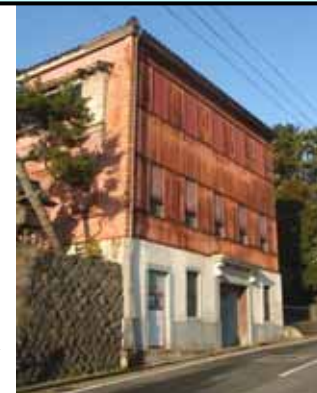
NKエージェント(旧割烹小幡のセットを再現)
